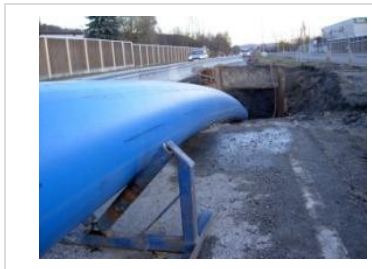
Figur 9.8 - PE-røret beskyttes mot ytre skader.
