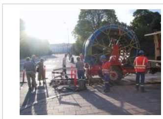
Figur 9.7 - PE-rør på kveilvogn.
