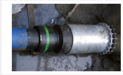
Figur 9.14 - Flensetilknytning til kum med varmforsinket styrerør.
