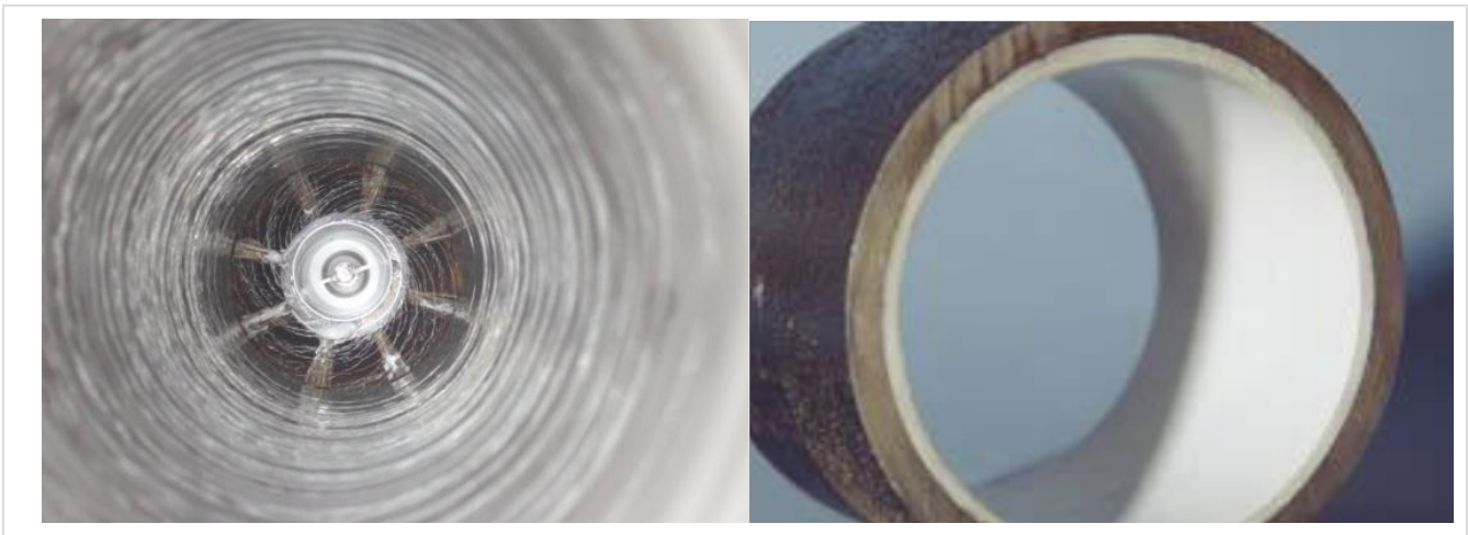
Figur 9.2 - Under og etter påføring av belegg. [Asplan Viak AS, NCC AS]
